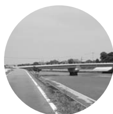
完成した橋梁架設工事（市道大湊川線）
